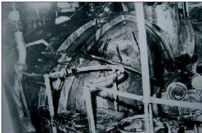
Condensador cubierto con petróleo en Máquina de Proa
