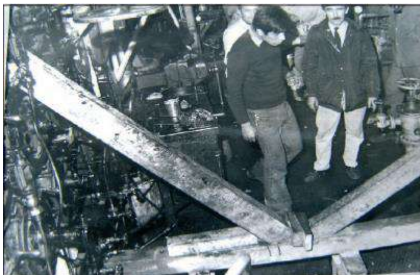
Apuntalamiento mamparo Salón 4 de calderas
