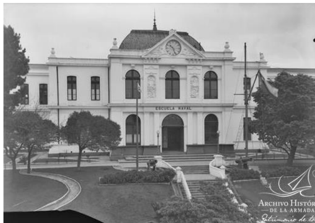
Nuevo frontis de la Escuela luego de los trabajos realizados con motivo del terremoto de 1906
