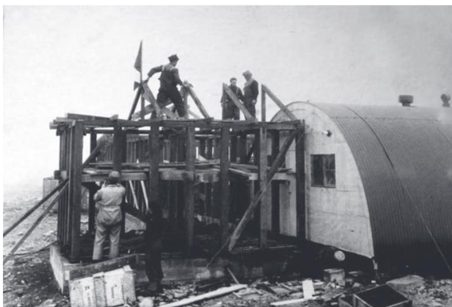
Construcción de la base Soberanía, compuesta por un hangar metálico y dos casas de madera
