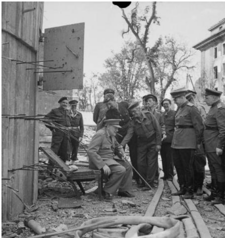
Churchill se sienta en una de las sillas dañadas del búnker de Hitler en Berlín.
