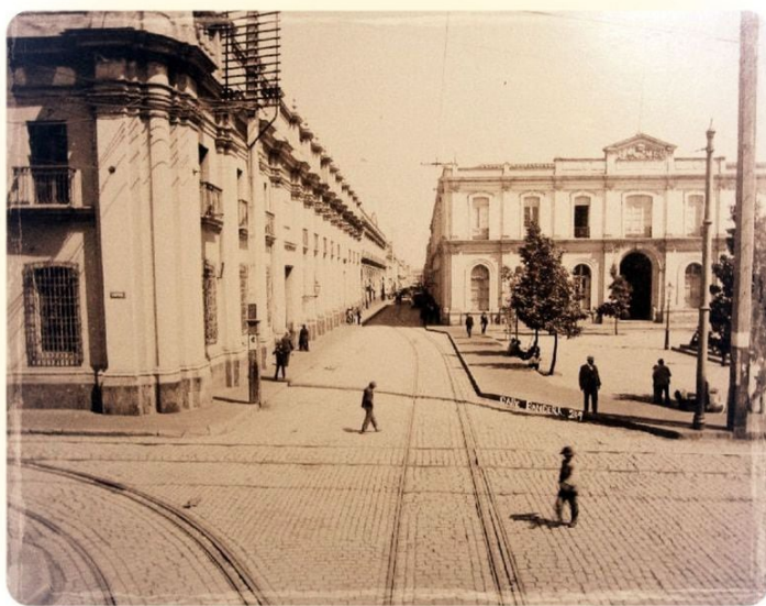
Edificio del Tribunal del Consulado
